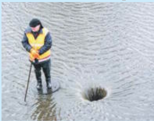
Agua va. Un trabajador municipal permanece de pie sobre una tapa de alcantarilla tras quitarla para evacuar el agua que dejó una tormenta en las calles de Riga, Letonia. FOTO: EFE
